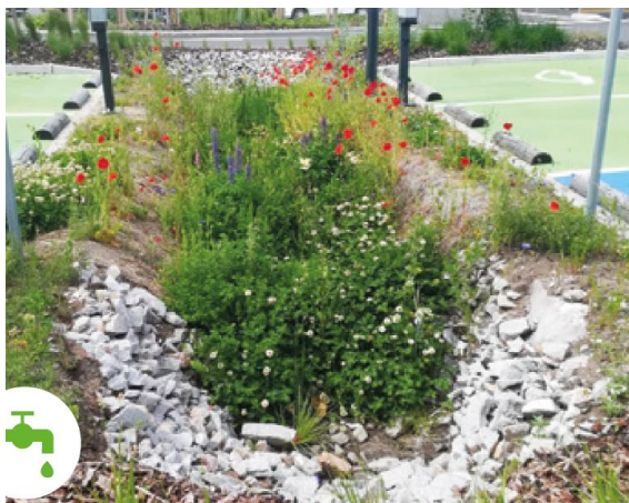
Noues d'infiltration (Leroy Merlin, magasin de Haguenau)
