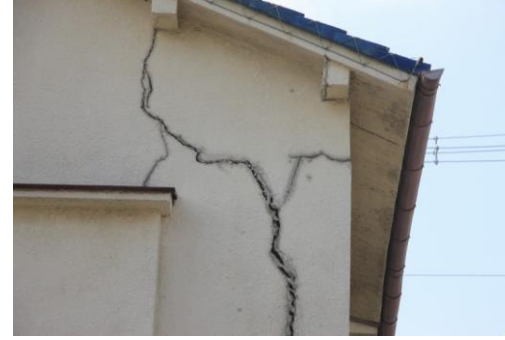
Dommmages induit par le phénomène de retrait- gonflement des argiles (10 millions de logements très fortement exposés en France)
