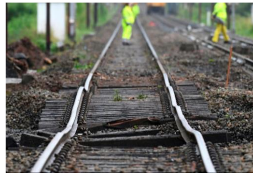
Destruction de rails due à de fortes pluies induisant une inondation
